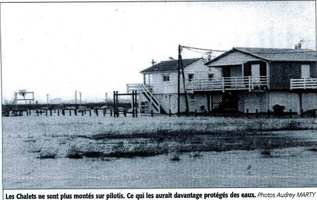
Les Chalets ne sont plus montés sur pilotis. Ce qui les aurait davantage protégés des eaux. Photos Audrey MARTY
