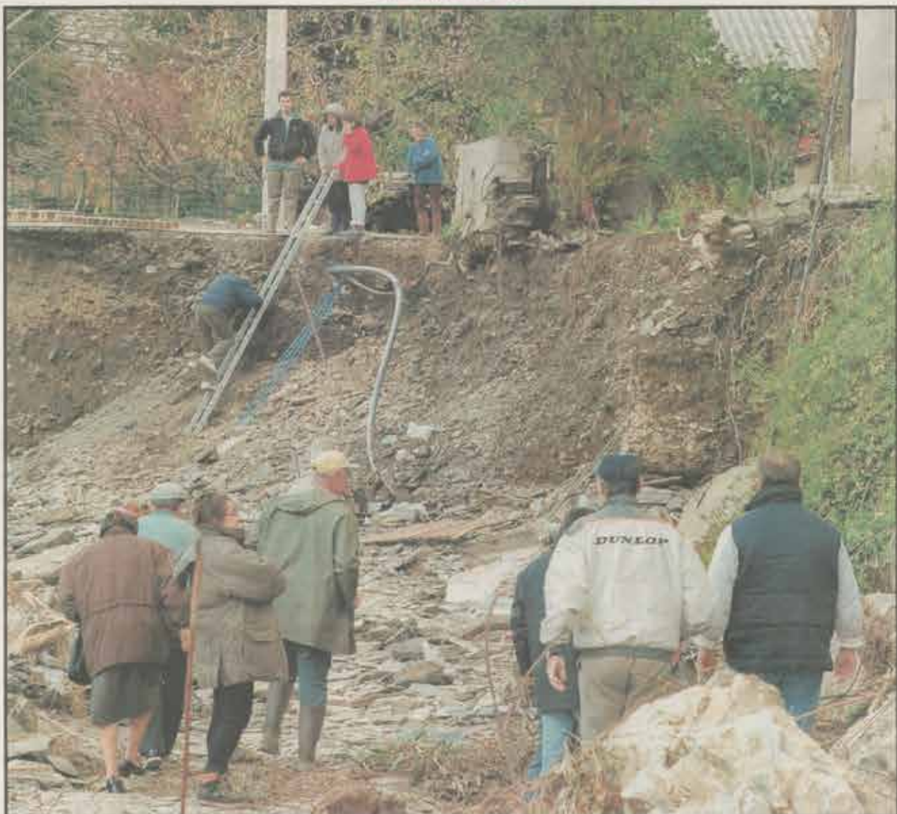
RIEUSSEC ET CASTANVIELS (AUDE). - Les ponts sont coupés entre ces deux localités, aux confins du Minervois et de la montagne Noire. Pour rallier leurs villages, les habitants sont contraints de descendre dans ce cratère laissé par la route défoncée sous les assauts du Rhodan qui, pour le coup, portait si mal son nom. Privés d'eau potable, de téléphone, d'électricité, ils ont réorganisé leur vie commune.
