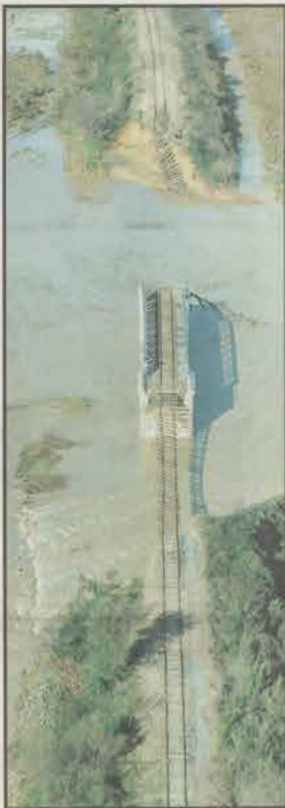
SALLELES-D'AUDE. - Le sol s'est dérobé sous le pont supportant la voie ferrée du petit train du Minervois.
